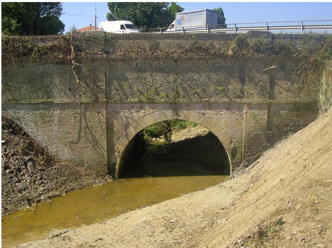
**Fig. 2. 12** Criticità idraulica per attraversamento con sezione insufficiente.
